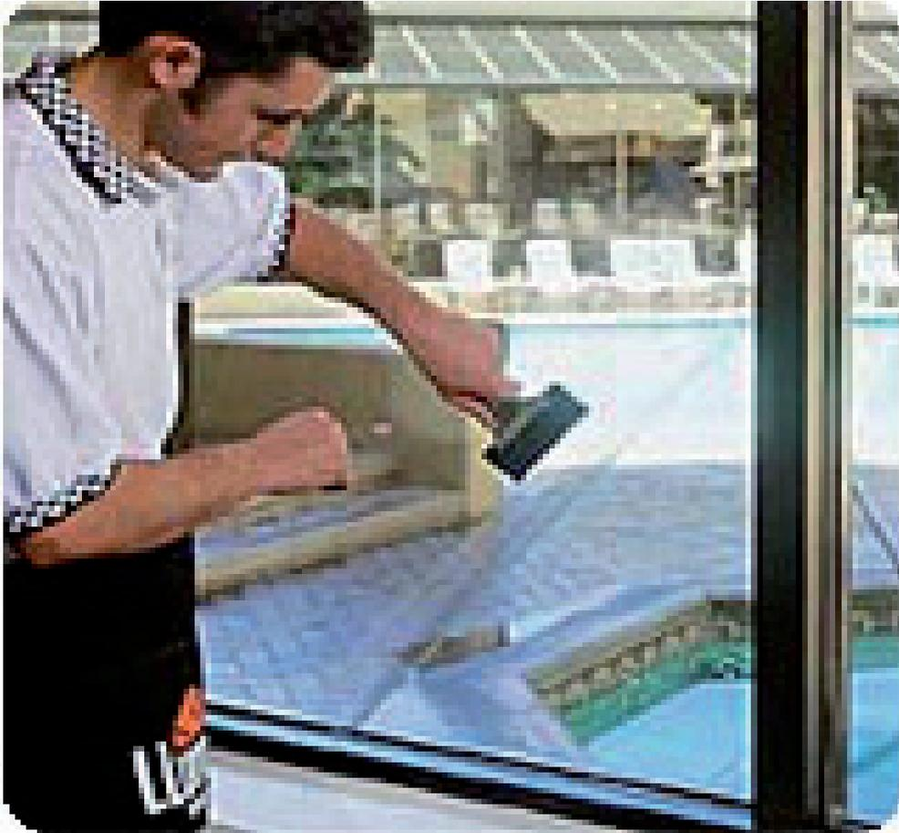
La graffiatura di una superficie vetrata (in genere vetrine, banche, centri commerciali) può essere evitata se sulla stessa superficie è stata precedentemente installata una pellicola neutra di almeno 100 micron di spessore. La composizione microstratificata del poliestere stesso sarà il più delle volte sufficiente ad assorbire tutta la forza del graffio o dell'incisione.
